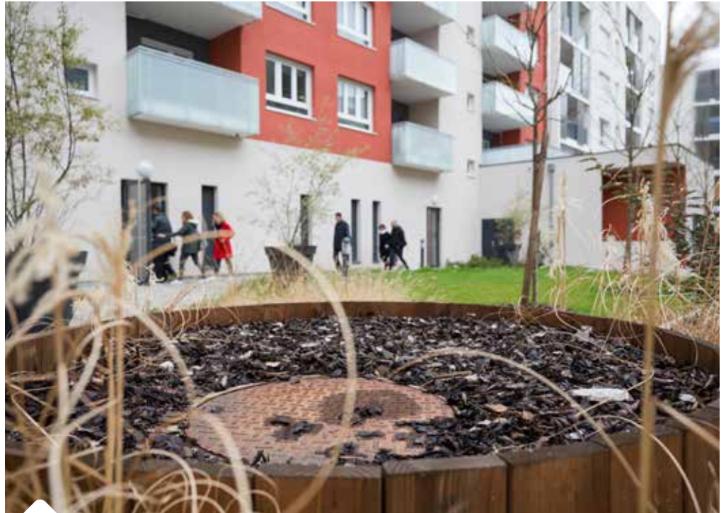
Au cœur de la ZAC Étoile, 90 logements sont chauffés à 80% par la chaleur récupérée dans le sol de l'immeuble - PHOTO JÉRÔME DORKEL
