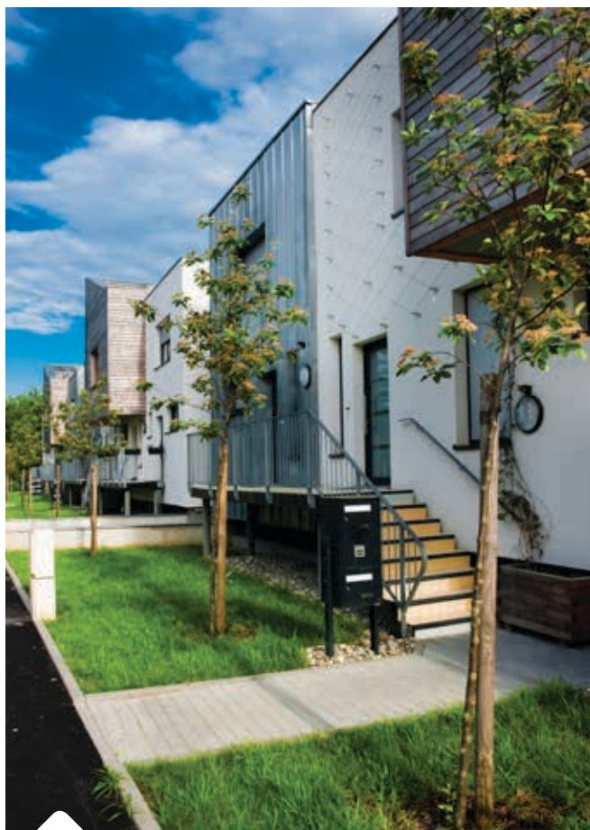
Le logement social se construit désormais en maisons en bande ou petits collectifs - PHOTO THIERRY SUZAN
