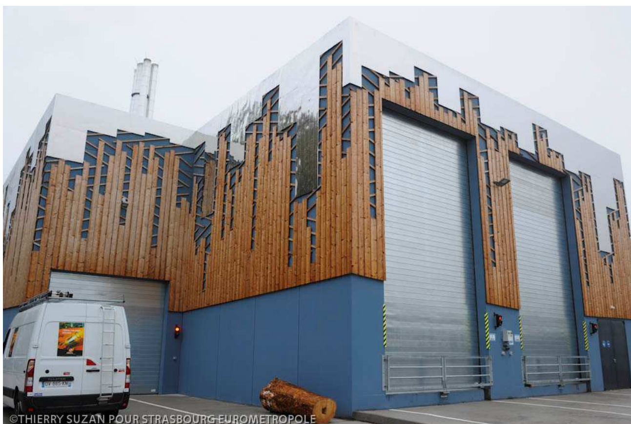
Chaufferie Eco2 Wacken
