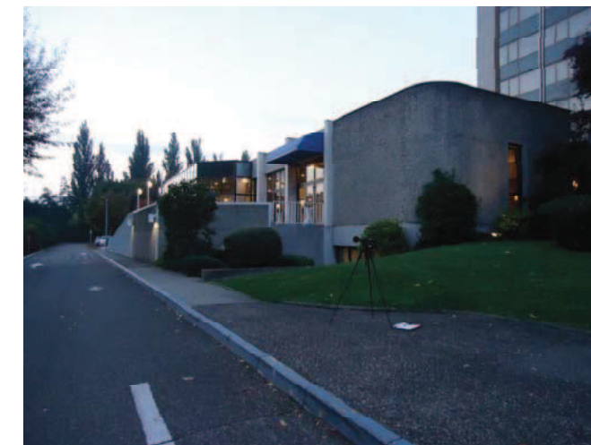
Pt4 (abords du Hilton face au site du projet)
