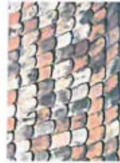
Couverture à simple recouvrement
