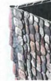
Couverture à double recouvrement
