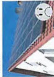
Les panneaux solaires sont mis en place **directement sur les chevrons, afin d'amoindrir l'épaisseur des panneaux sur le toit.**
