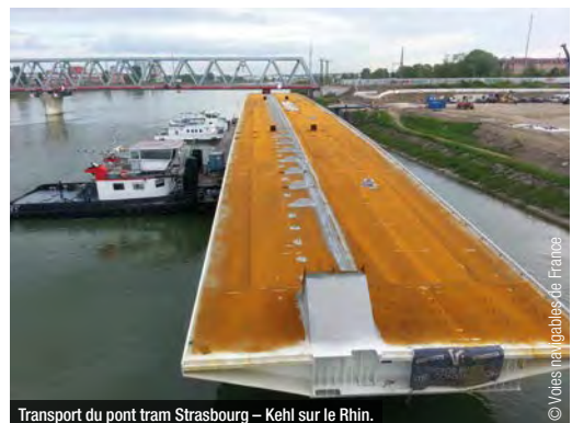
Transport du pont tram Strasbourg – Kehl sur le Rhin.
