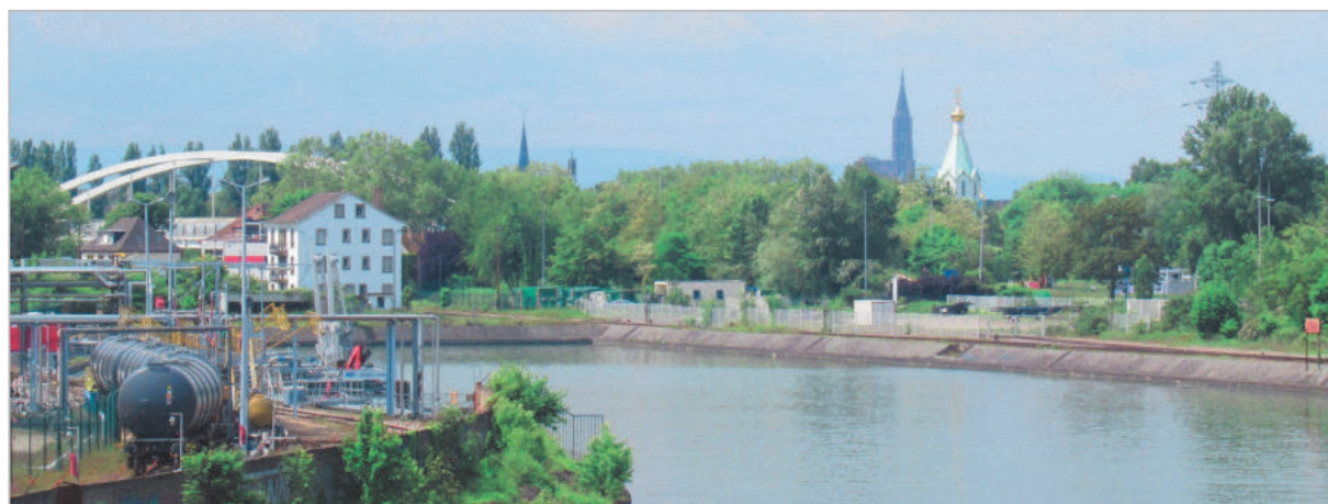
Depuis le pont du bassin Auberger
