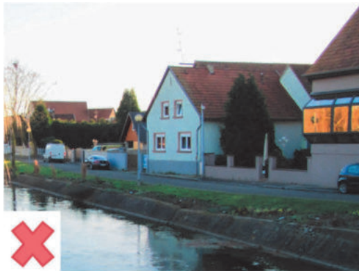
1. Présence de berges fortement aménagées et imperméabilisées avec de nombreux enrochements
