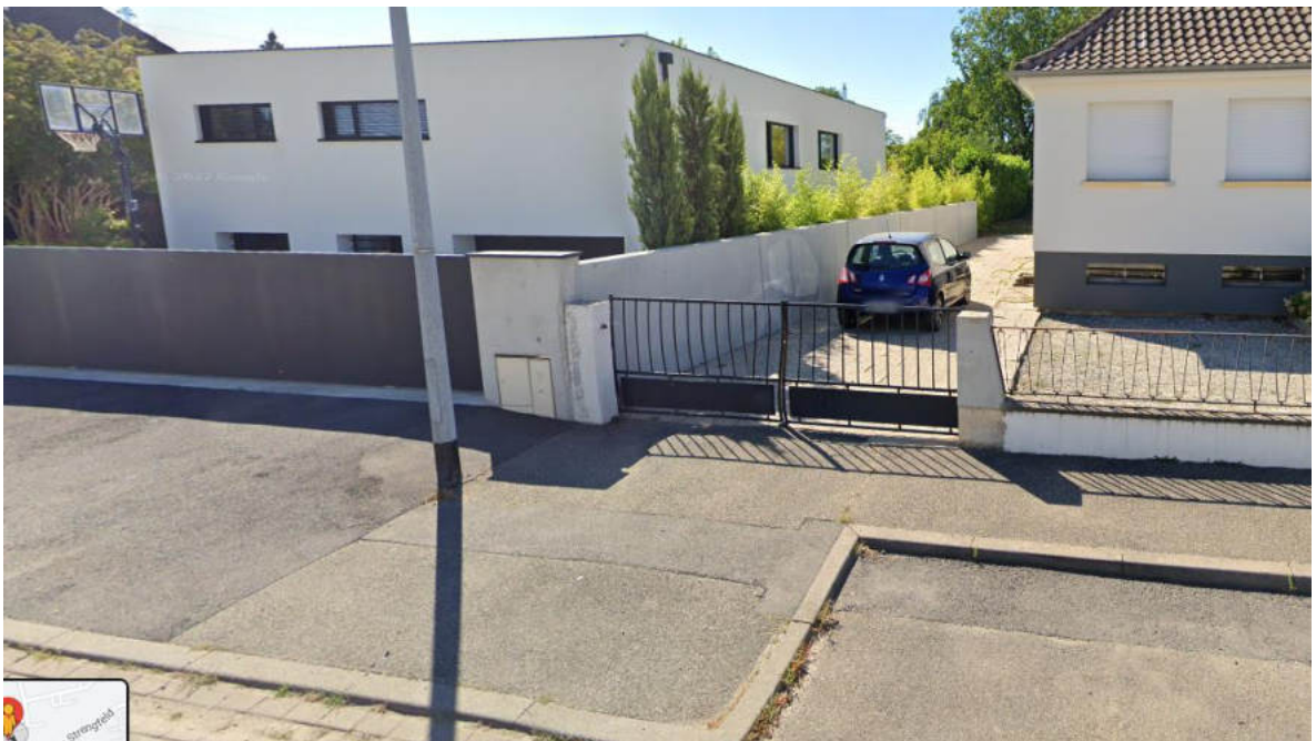
Photographie des propriétés sises au 7 et 8 de la rue Philippe Bellocq à Mundolsheim au milieu desquelles la liaison piétonne/cycle est supposée passer : or on voit bien que la réalisation de cette voie, de trois mètres de large, n'est pas possible au regard du caractère contraint des deux parcelles et de la présence d'éléments bâtis.
