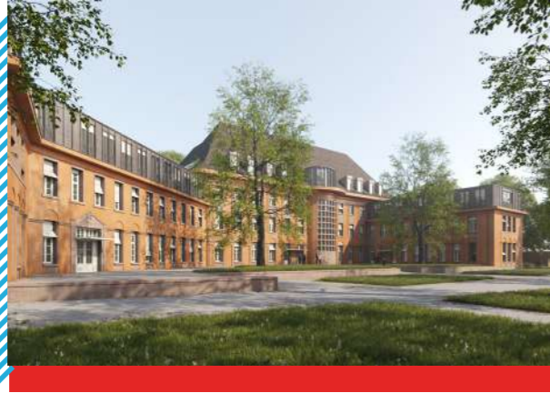
9 000 m 2 (avec son extension) le pavillon « ORL » (ancienne clinique d'oto-rhino-laryngologie) construit en 1920, entièrement rénové et étendu.
