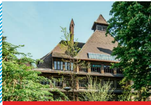
1 000 m 2 le pavillon Blum sera totalement réhabilité.
