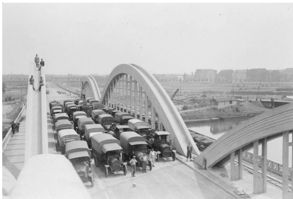
Pont de la Citadelle, épreuve de charge, milieu des années 30 (Archives de la Ville de Strasbourg)
