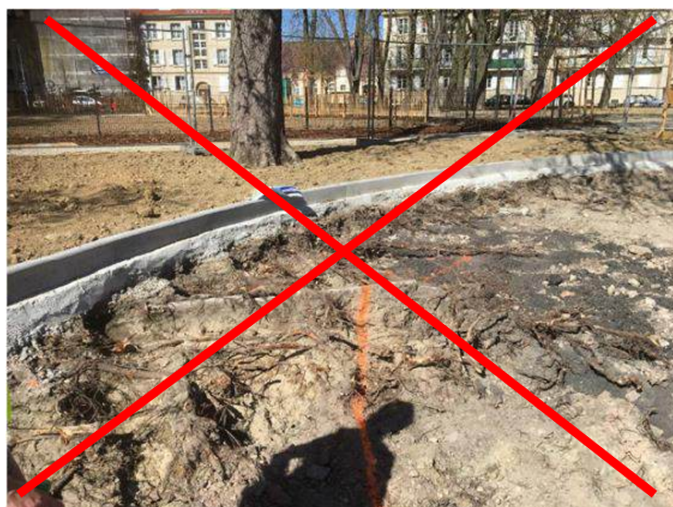
Photo 13 et 14 : Exemples de non-respect des prescriptions : mise à nu du système racinaire / racines sectionnées par arrachements. Impact défavorable sur la viabilité de l'arbre
