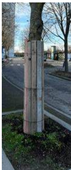
Photo 9 : Photos d'un exemple de protection des troncs contre les chocs
