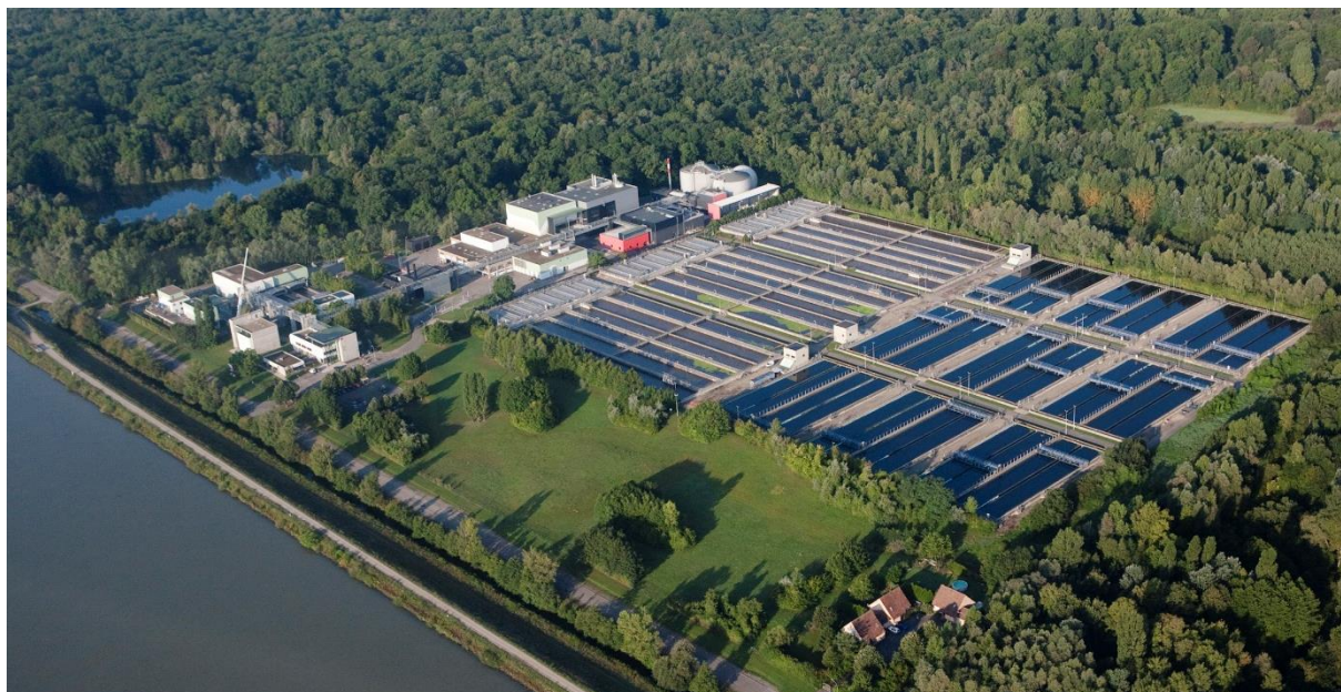
Station d'épuration de La Wantzenau © Jérôme Dorkel
