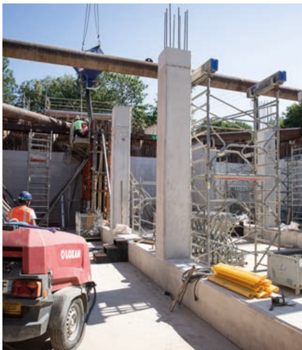
Le bassin d'orage de l'Elsau sera enterré à la manière de celui de Lampertheim actuellement en construction, visible ci-dessus.
