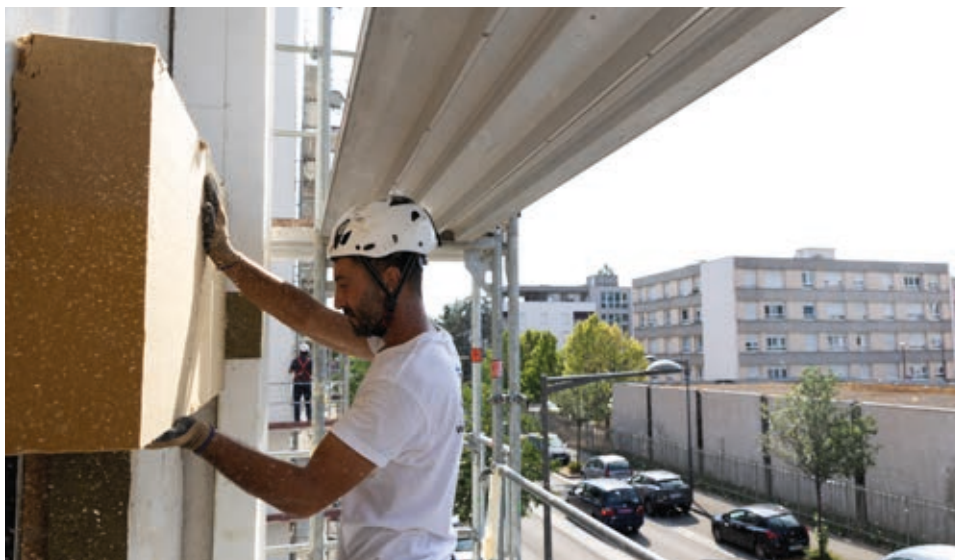
Les logements devraient passer à un niveau de performance énergétique B, contre une étiquette D avant les travaux.
