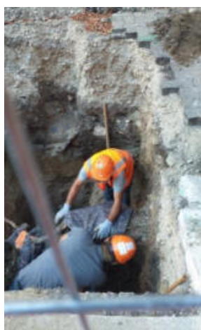
Photo 12 : Mise en place d'un feutre géotextile + substrat autour d'une racine mise à nue lors d'un chantier de terrassement
