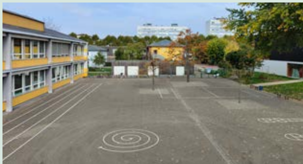
Transformation de la cour de l'école La Canardière (Meinau), avant...
