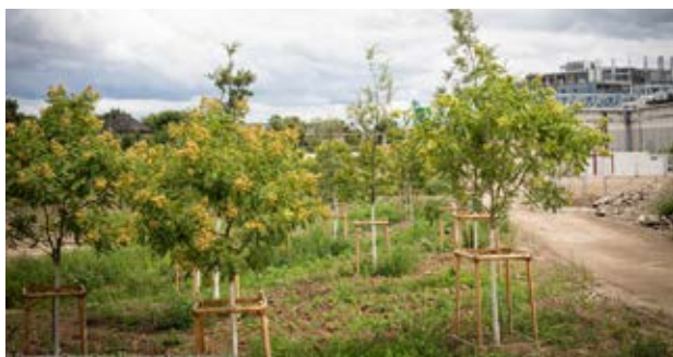
Travaux du futur parc Archipel 2 (Wacken)
